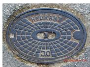
Löschwasserentnahmeeinrichtungen (Über- und Unterflurhydranten) sind einschließlich ihrer Kennzeichnungen von Aufbauten oder Lagerungen im Umkreis von 1 Meter freizuhalten und müssen jederzeit zugänglich sein.
